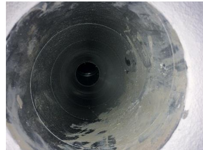
Figura 8 - Canale non protetto durante le fasi di lavorazione. È necessario pulirlo perfettamente prima della consegna dell'impianto.
